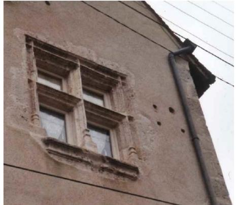
Un **meneau** est un élément structural vertical en pierre de taille, bois ou fer qui divise la baie d'une **fenêtre** ou d'une porte. L'objectif principal du **meneau** est d'être un soutien structurel à un arc ou linteau au-dessus de cette ouverture.
